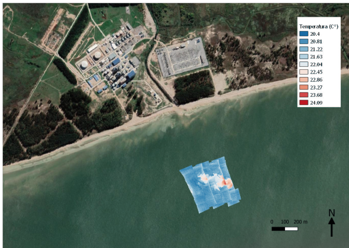
Figura 9: Vista de la Central de Punta del Tigre, mostrando la pluma de agua caliente medida desde una aeronave no tripulada con una cámara infrarroja térmica.
